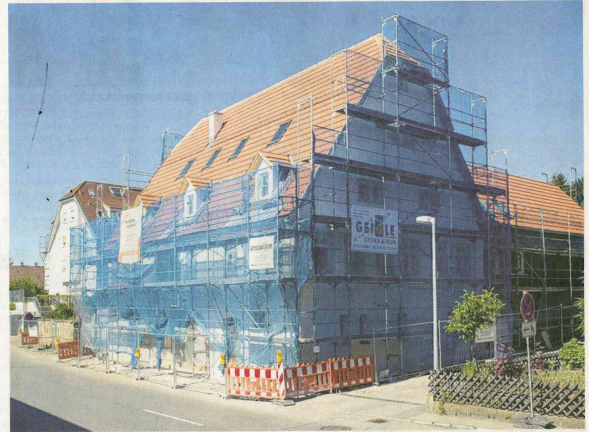
Der Digelhof in Maichingen ist ein historisches, unter Denkmalschutz stehendes Gebäude. Derzeit wird das Haus von der Baugenossenschaft Sindelfingen saniert. Im historischen Teil und in einem Anbau werden zusammen fünf Wohnungen eingerichtet.
